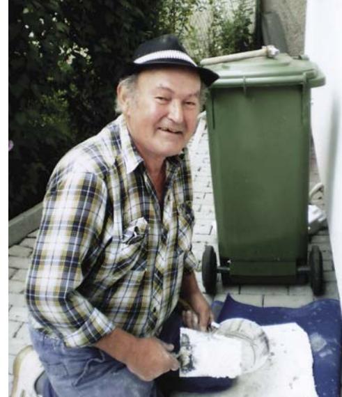
Dedko Rudolf Mečár pomohol pri rekonštrukcii budovy
